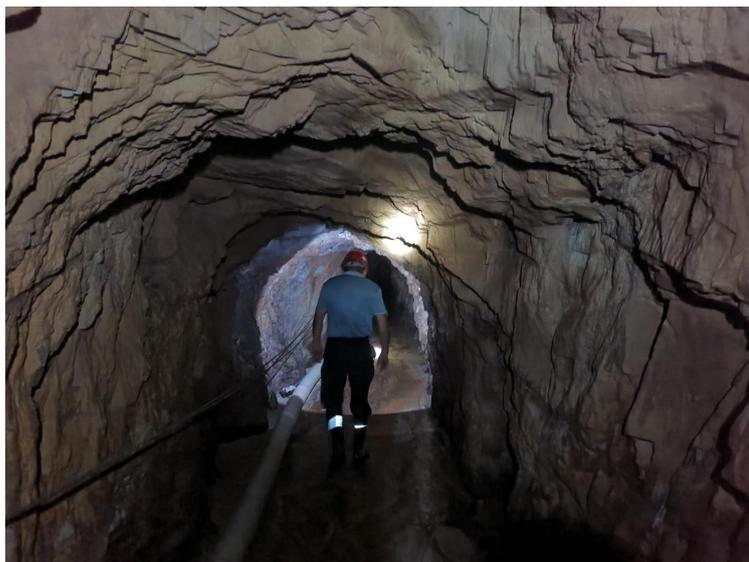
图 2-6 排洪隧洞未衬砌段
